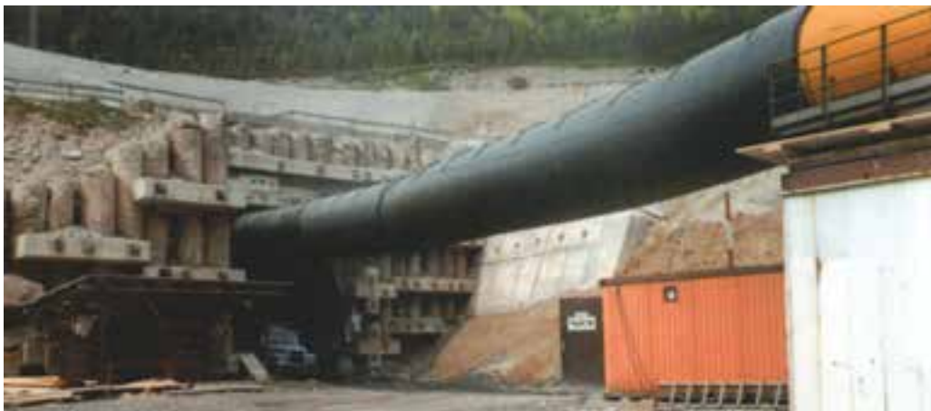
شکل ۱۳-۹- آویز جهت نصب لوله‌های تهویه
