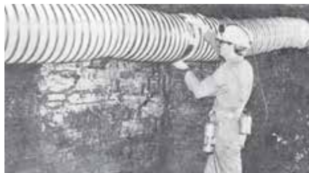
۹-۹- نحوه نصب لوله‌های پاره‌ای در تونل
