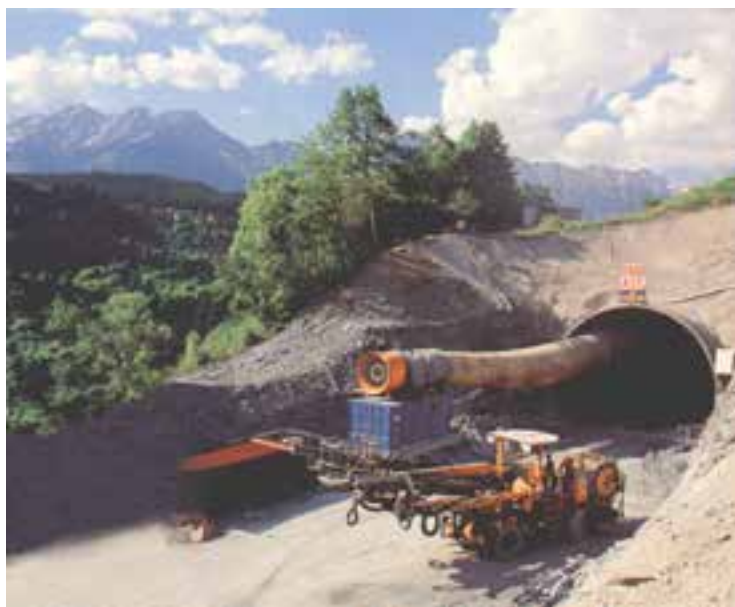
۱۴-۹- لوله‌های فلزی تهویه با اتصال جوشکاری شده
