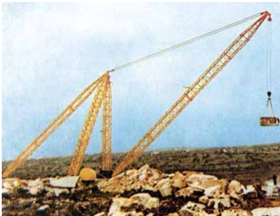
شکل ۲۲-۵- جرثقیل مخصوص حمل بلوک‌های سنگ استخراجی
