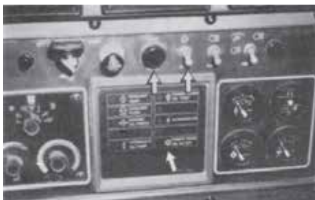
شکل ۵-۴۹- آزمایش سیستم هشداردهنده
