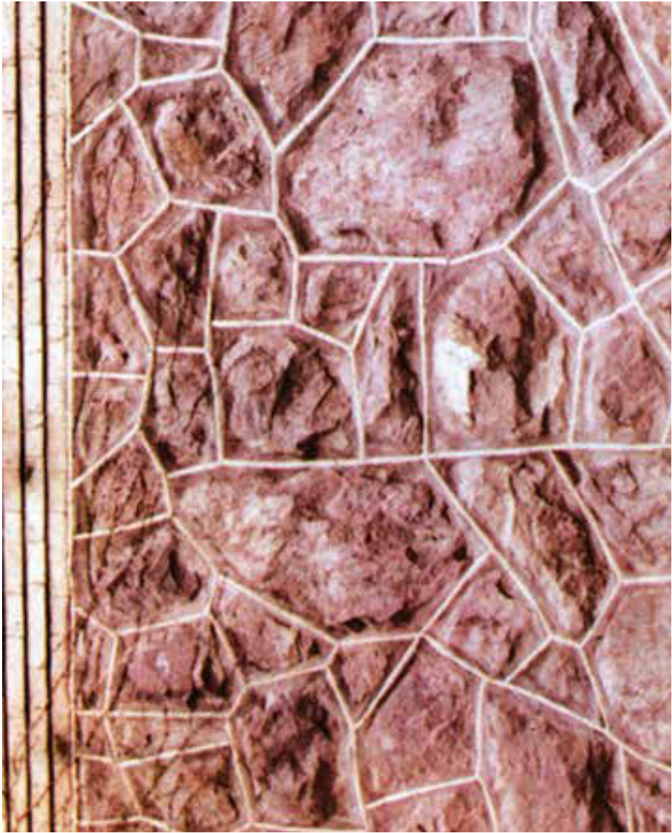
شکل ۲-۵- نمونه‌ای از کاربرد سنگ‌ها در دیوار ساختمان
