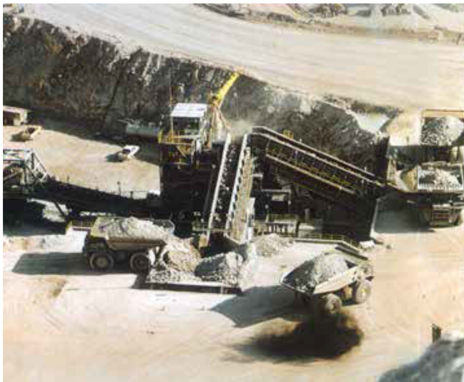
شکل ۳۹-۴- کامیون معدنی در حال تخلیه بار به داخل سنگ شکن
