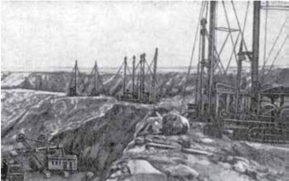
شکل ۴۵-۴- استقرار برج حفاری در امتداد پله‌های حفاری
