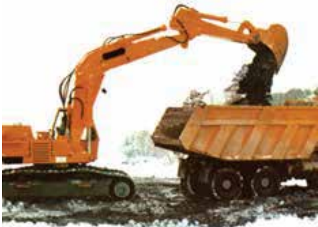
شکل ۲۳-۴- کج بیل در حال حفر کانال
