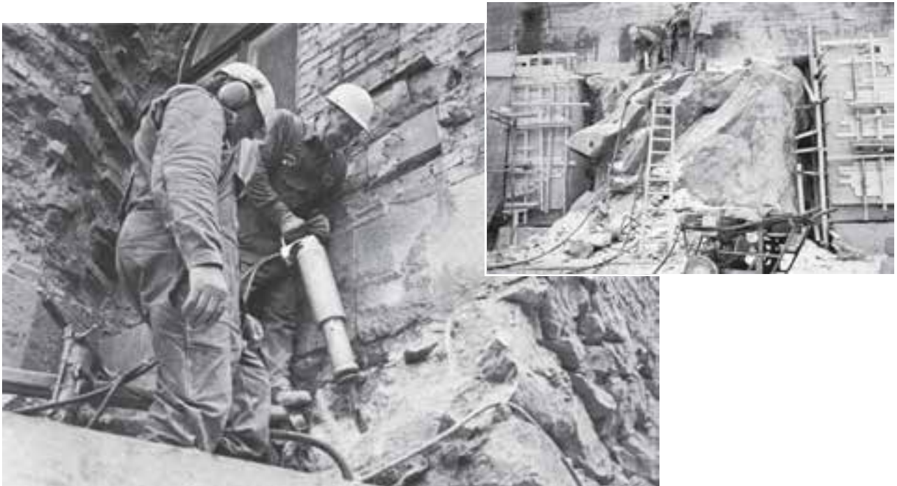
شکل ۱۵-۲- نحوه خرد کردن سنگ‌هایی که به صورت قطعات درشت بر روی هم ریخته‌اند.
