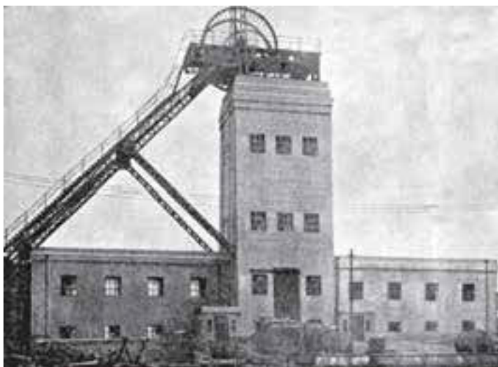
شکل ۱۴-۱- تأسیسات بیرونی آسانسور چاه معدن
