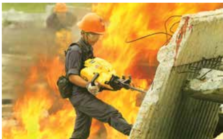
شکل ۱-۷- خرد کردن بتون
