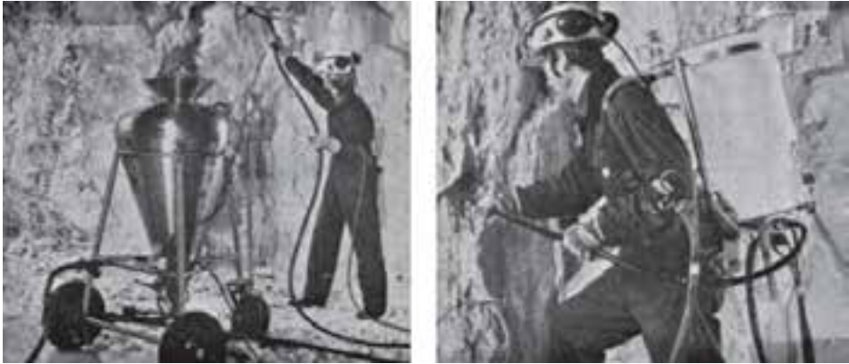
شکل ۸-۸- دستگاه خراج‌گذار آنفو که با هوای فشرده کار می‌کند.
