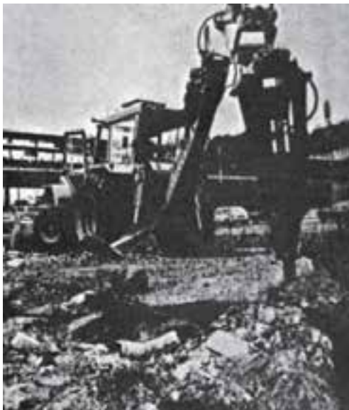
شکل ۲-۴- بیک بزرگ در هر دقیقه ۵ تا ۱۰ ضربه وارد می‌کند.
