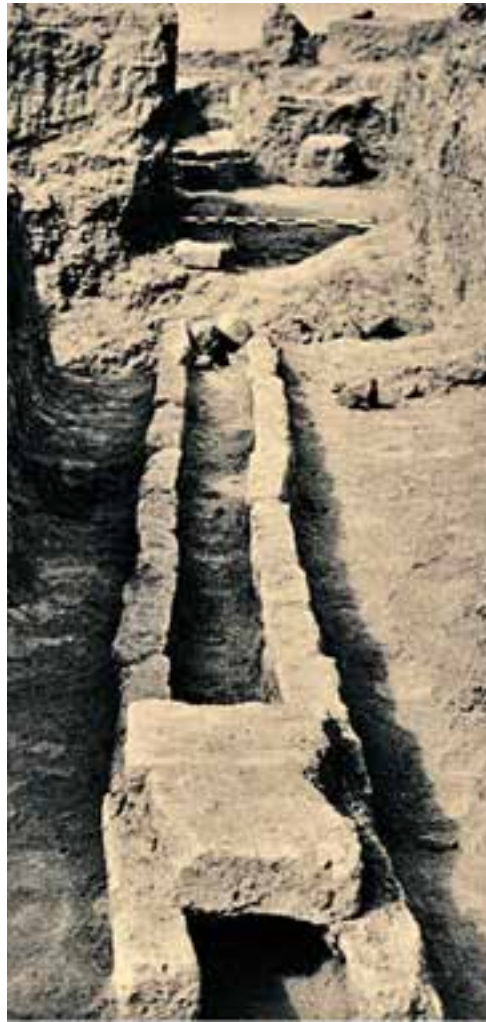
▲ شکل ۱-۵- روش آبیاری با لوله‌های سفالین در شهرهای دوره‌های باستان ایران (منطقه چغامیش)
