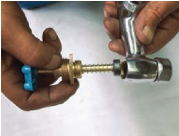
ب- قرار دادن کف تراش در شیر
