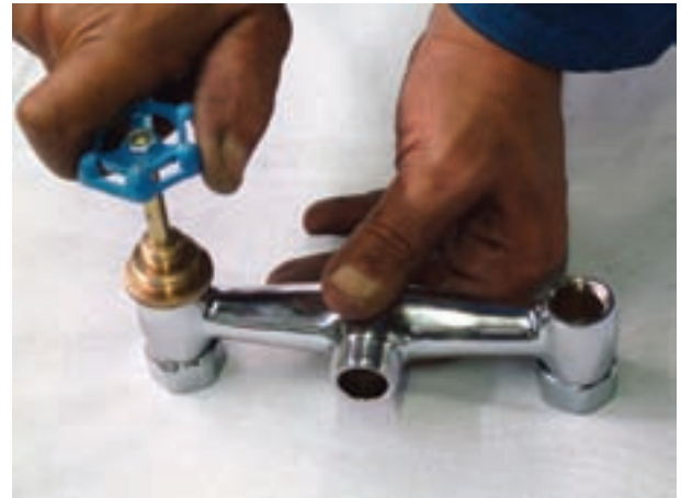
ج- عمل کف تراشی شیر
