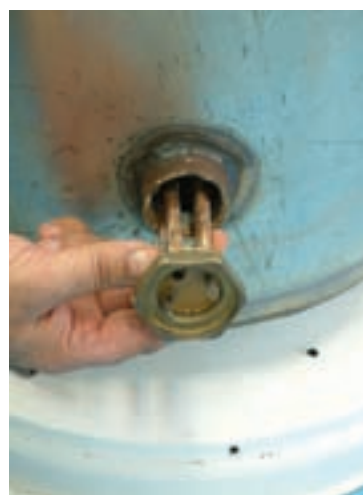
شکل ۲۲-۱۳- هیترهای برقی مورد استفاده در آب‌گرم‌کن مخزنی برقی
