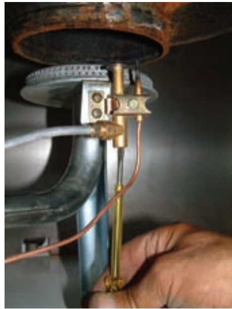
شکل ۱۳-۱۳- تنظیم شعله ی پیلوت
