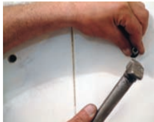
۳- کوبیدن رول‌پلاک در درون سوراخ‌ها
