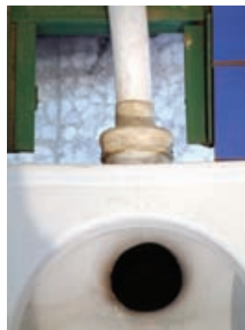
الف- اتصال لوله‌ی تخلیه و رابط لاستیکی به مجرای ورودی کاسه توالت
