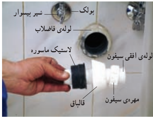
۲- عبور دادن لوله‌ی سیفون افقی از درون مهره‌ی سیفون، قالپاق و لاستیک ماسوره
