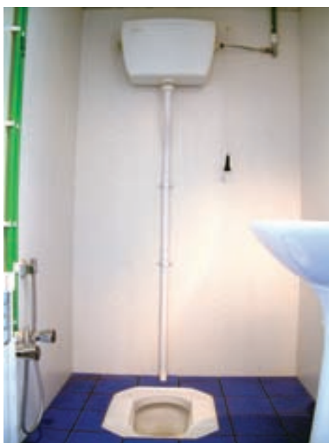
شکل ۳۸-۱۰ اتصال مخزن فشاری به کاسه توالت ایرانی
