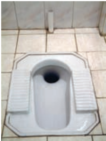
ب- قرار دادن کاسه توالت بر روی سیفون شترگلو و فرش کردن کف توالت
