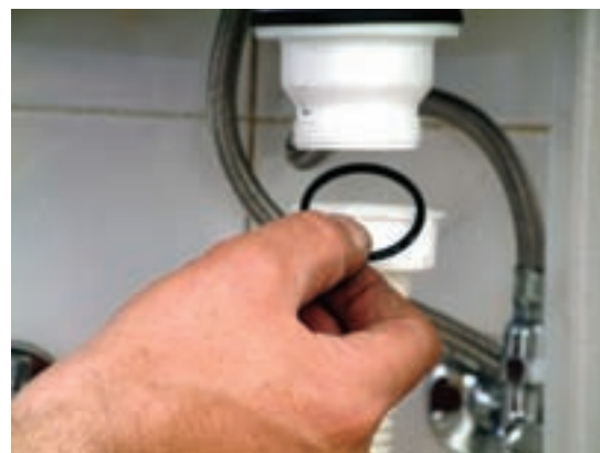
۴- قرار دادن واشر لاستیکی در درون مهره‌ی سیفون عمودی
