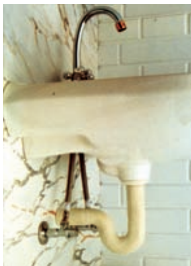
شکل ۳۱-۱۰- نصب دست شویی
