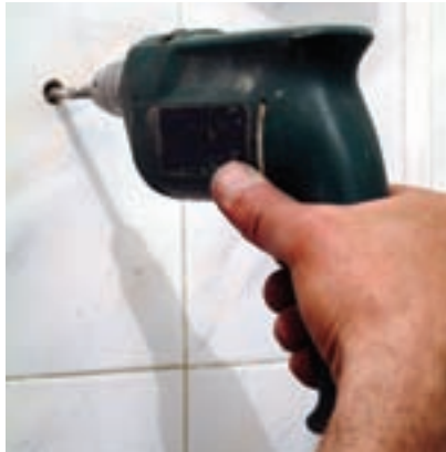
۲- سوراخ کردن محل پیچ‌های روکارا
