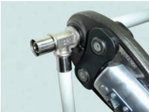
شکل ۱۱-۳- نحوه‌ی کار با دستگاه پرس
