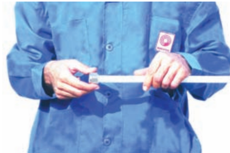
شکل ۱۵-۳- نحوه‌ی جا زدن مهره ماسوره
