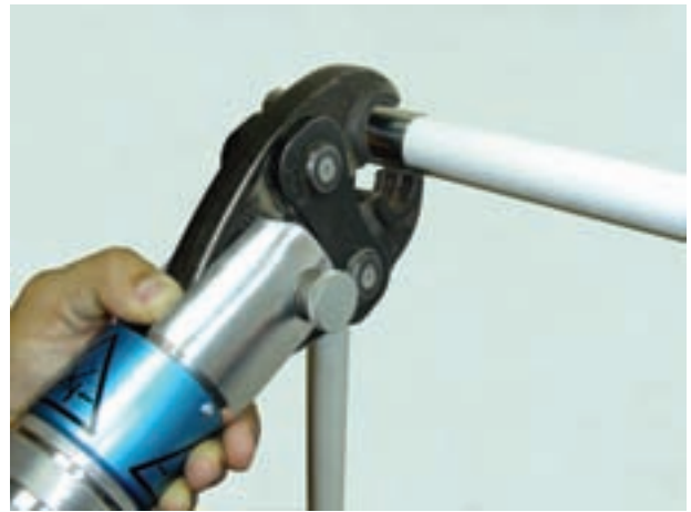
شکل ۱۱-۳- نحوه‌ی کار با دستگاه پرس
