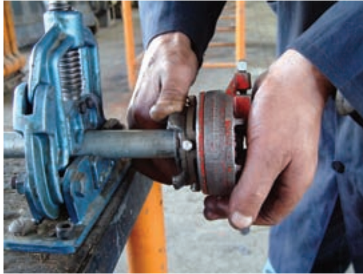
شکل ۱-۴۰- عبور حدیده از روی لوله و بستن چهار نظام
