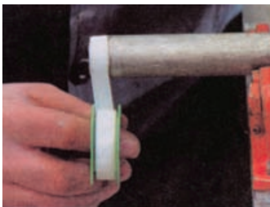
شکل ۶۱-۱- پیچیدن نوار تفلون به سر لوله
