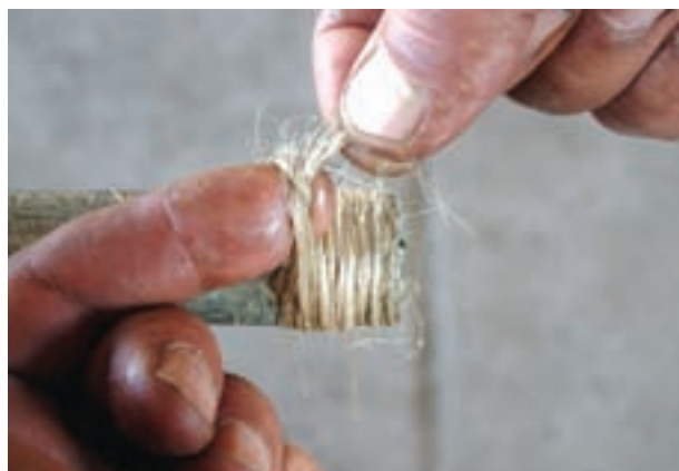
ج- کنف پیچی سر دنده (گره زدن)
