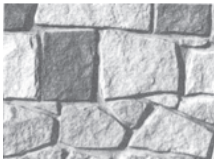
شکل ۱۱-۲- دیوار با سنگ چندوجهی سرتراش رجدار
