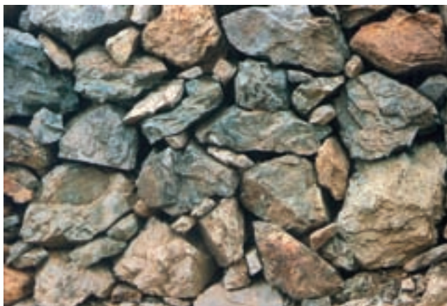
شکل ۸-۲- نمای دیوار لاشه چینی شده بدون ملات
