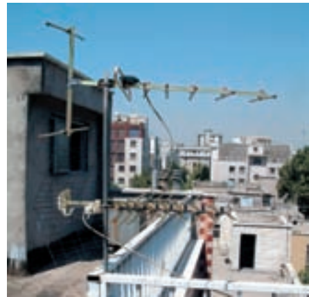
شکل ۱۸-۴ آنتن VHF و UHF روی دکل
