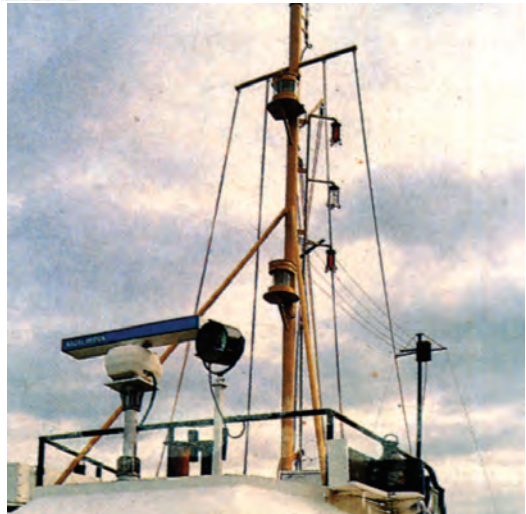
شکل ۴-۱۰ و ۴-۱۱- تصاویری از آنتن رادارهای ناوبری
