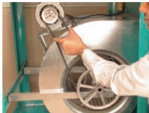
الف- طرز قرار گرفتن تسمه روی پولی‌ها
