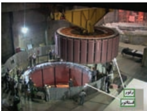
شکل ۸- رتور نیروگاه آبی سد شهید عباسپور در حال قرارگیری در استاتور
