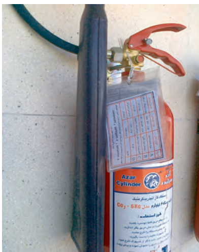
شکل ۱۲-۱- پلاک‌های مشخصات و تاریخ شارژ نصب شده روی کپسول
