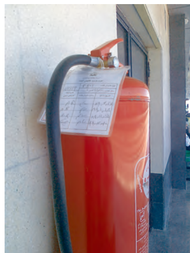
شکل ۱۲-۱- پلاک‌های مشخصات و تاریخ شارژ نصب شده روی کپسول
