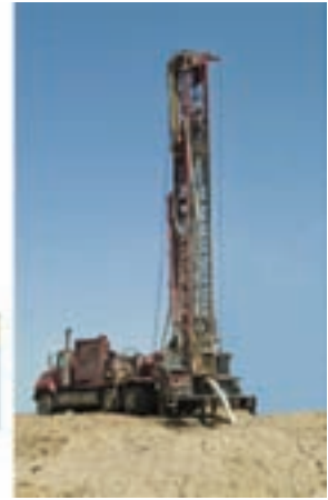
دکل حفاری چاه آب
