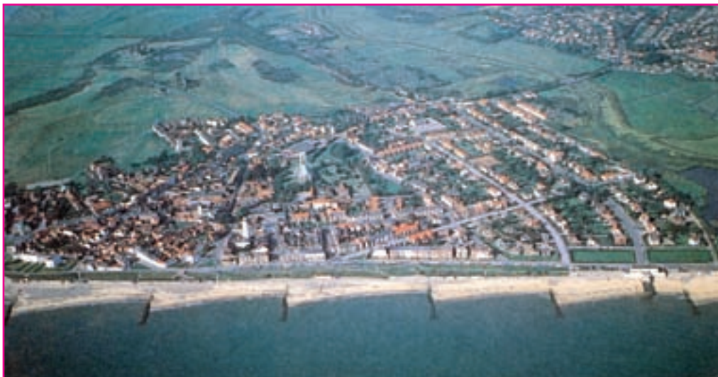
شکل ۸- احداث حفاظ در سواحل ماسه‌ای
