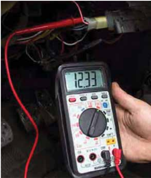
شکل ۲۸-۱۱- اندازه‌گیری ولتاژ در ترمینال ورودی سوئیچ
