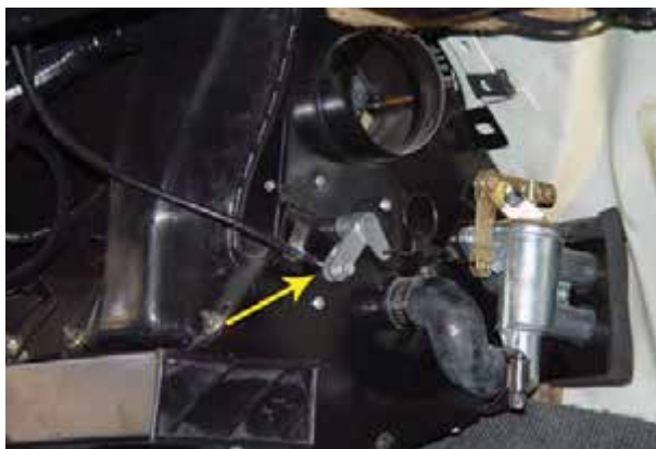
شکل ۴-۳۲- اتصالات دریچه‌ی بخاری
