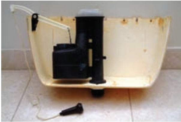
شکل ۳-۲۰۷- نصب پمپ تخلیه درون مخزن فشار
