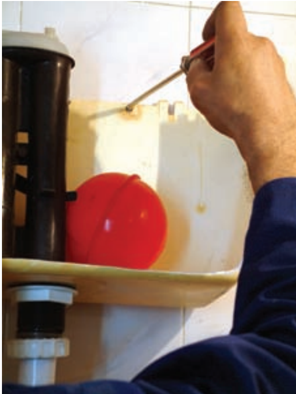
شکل ۲۱۳-۳- نصب مخزن فشاری به دیوار
