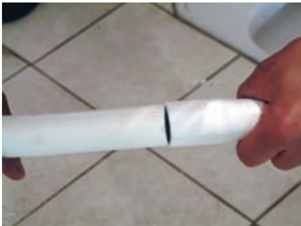
شکل ۲۰۶-۳- جا زدن لوله‌های تخلیه در درون یکدیگر
