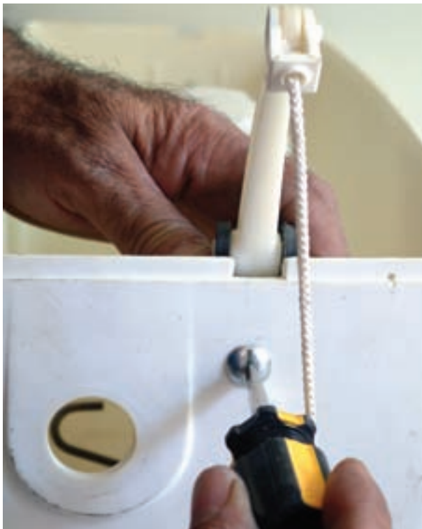
شکل ۳-۲۰۹- اتصال اهرم به بدنه‌ی مخزن فشاری
