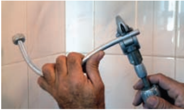
شکل ۲۲۲-۳- بریدن لوله‌ی پیسوار به وسیله‌ی لوله‌بر
