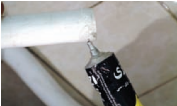
شکل ۲۰۵-۳- زدن چسب به لوله‌های تخلیه
