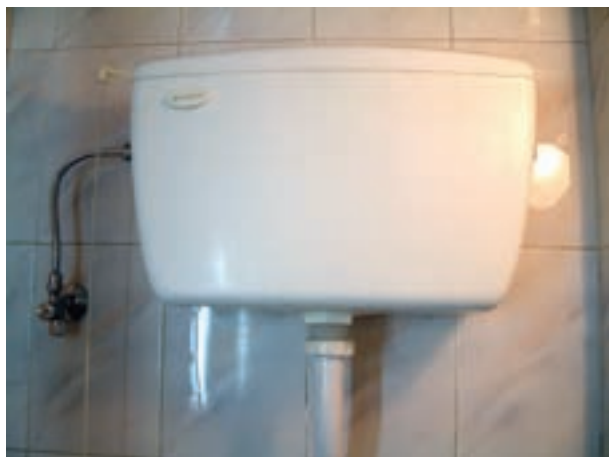
نصب مخزن فشاری
