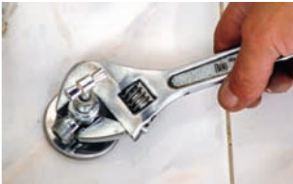
شکل ۲۲۰-۳ سفت کردن شیر پیسوار با آچار فرانسه
