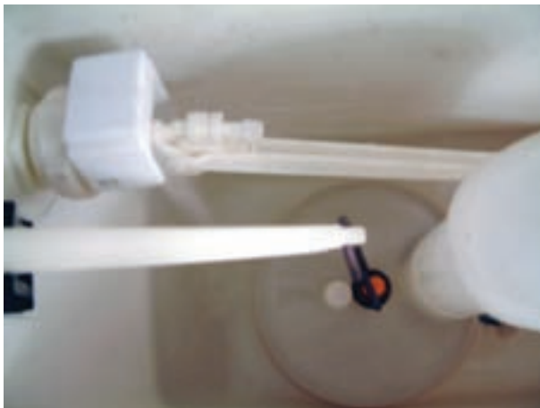
شکل ۲۲۴-۳- بر شدن مخزن فشاری
