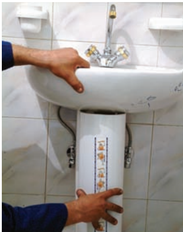
شکل ۳-۵۸- قرار دادن پایه‌ی دست‌شویی در زیر آن
