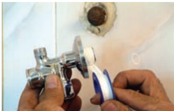
شکل ۳-۴۶ پیچیدن نوار تفلون بر روی سردنده‌ی شیر پیسوار
