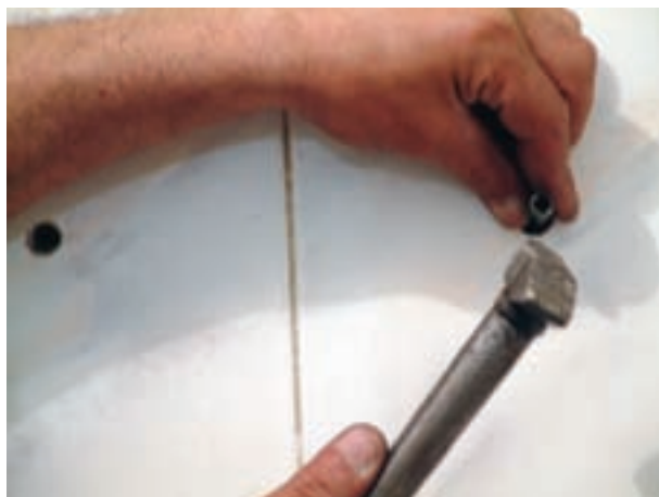
شکل ۳-۴۲- کوبیدن رولپلاک‌ها در درون سوراخ‌ها
