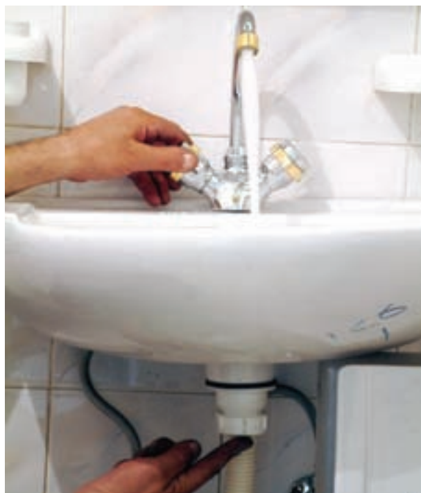
شکل ۳-۵۷- عمل کنترل نشت آب از محل‌های اتصال
