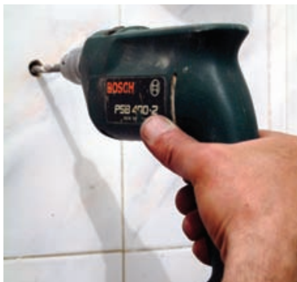
شکل ۳-۴۱- سوراخ‌کاری محل نصب پیچ‌ها
