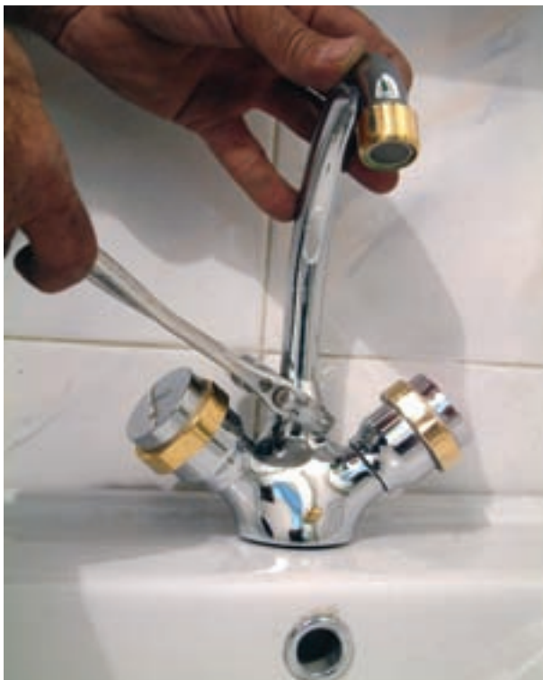
شکل ۳-۵۱- سفت کردن مهره‌ی عَلم شیر با آچار فرانسه
