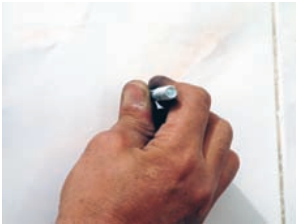
شکل ۳-۴۳- بستن پیچ‌ها در درون رولپلاک‌ها با دست
