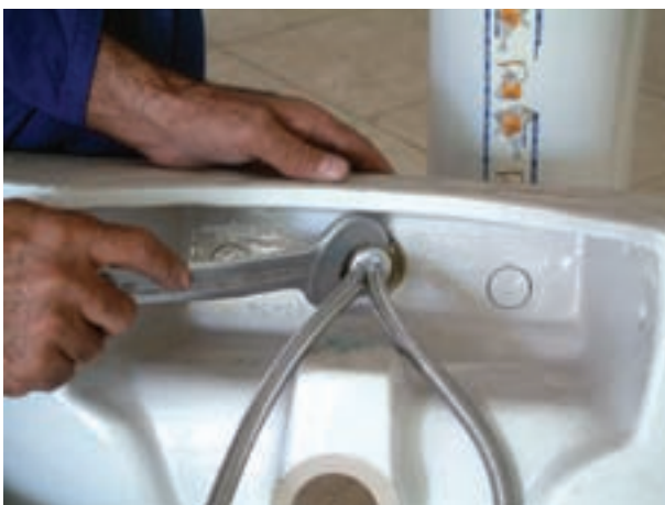
شکل ۳-۳۹- نصب شیر مخلوط توکاسه بر روی دست شویی
