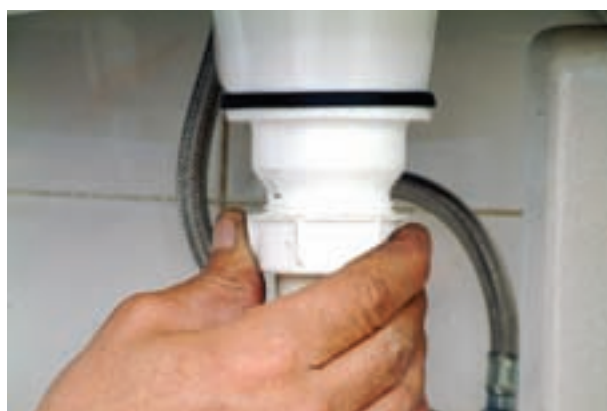
شکل ۳-۵۶- بستن مهره‌ی لوله‌ی عمودی سیفون به زیراب
