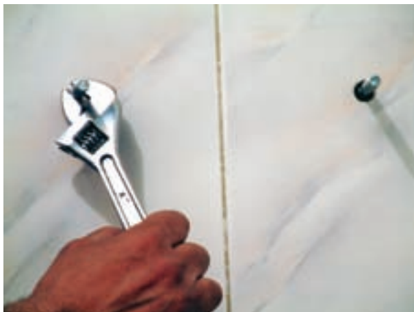
شکل ۳-۴۴- سفت کردن پیچ‌ها در درون رولپلاک‌ها
