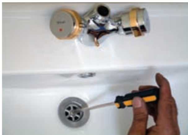
شکل ۳-۴۰- نصب زیراب بر روی دستشویی
