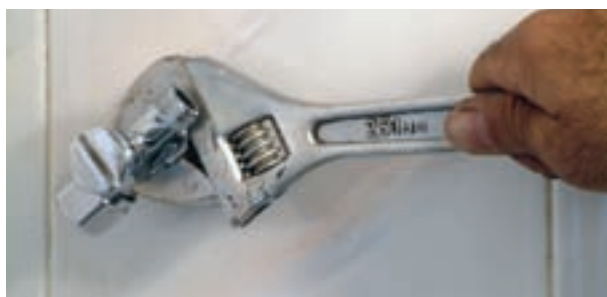
شکل ۳-۴۸ سفت کردن شیر پیسوار با آچار فرانسه
