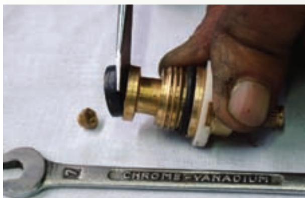
شکل ۲-۶۳- تعویض واشر
