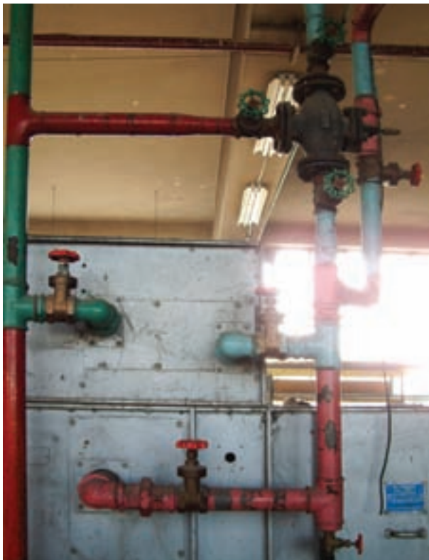
شکل ۲-۸۳ – مورد استفاده‌ی شیر فلکه در تهویه‌ی مطبوع
