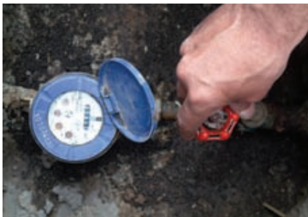
شکل ۲-۶۰ بستن شیر فلکه‌ی اصلی آب ساختمان
