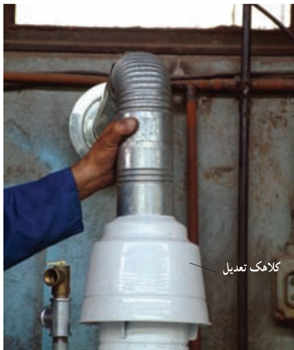
شکل ۹۳-۱ کلاهک تعدیل مورد استفاده در آب گرمکن های مخزنی گازسوز
