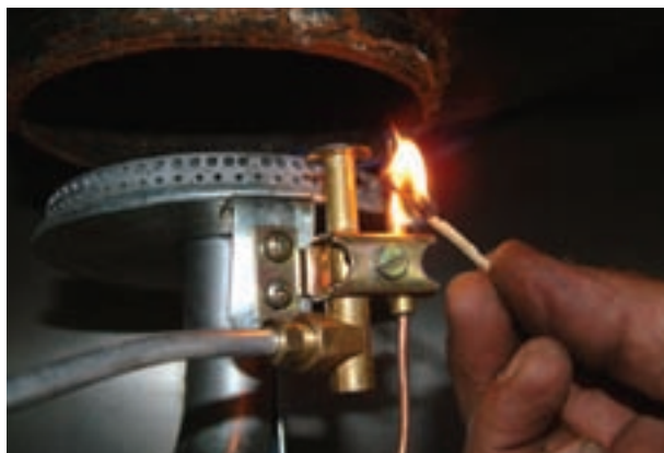
شکل ۱-۱۰۵ مشتعل کردن شمعی به وسیله‌ی شعله‌ی کبریت
