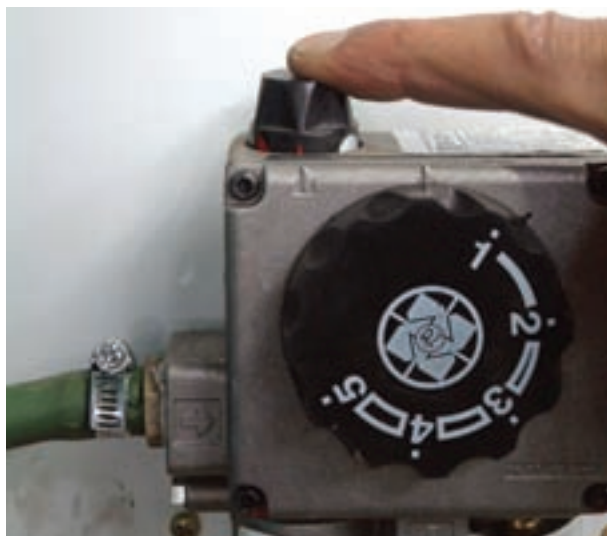
شکل ۱-۱۰۴ در حالت شمعی قرار دادن و پایین نگه داشتن دگمه‌ی فرمان
