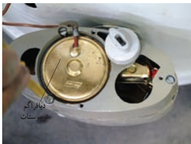
شکل ۵۵-۱- ب - دیافراگم ترموستات
