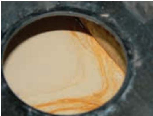
شکل ۱۶۲-۱۶. چسب ذوب شده و آماده لبه چسبانی است.
