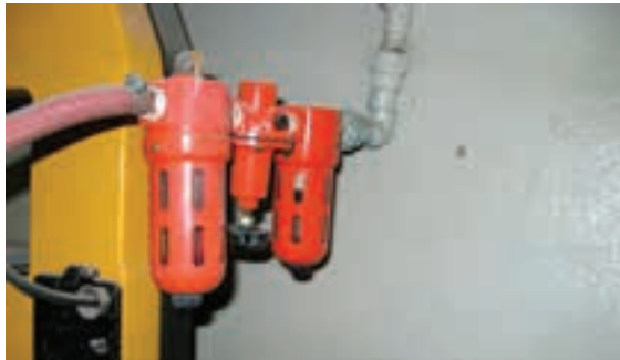
شکل ۱۴۸-۱۶- فیلتر رطوبت هوای فشرده.
