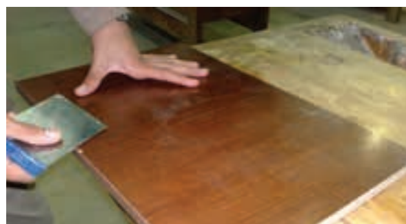
شکل ۱۴-۱۴۱- برداشتن اضافه نوار با لیسه.
