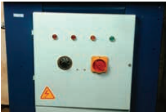
شکل ۱۲۶-۱۶- کلید روشن کردن هیتر و کلید تنظیم حرارت و چراغ‌های هشدار دهنده.
