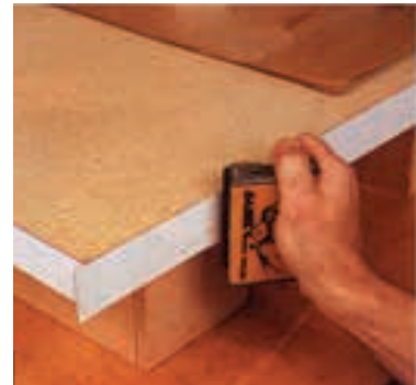
شکل ۶۶-۱۶ فشردن نوار به سطح چسب فورده با مشتی.
