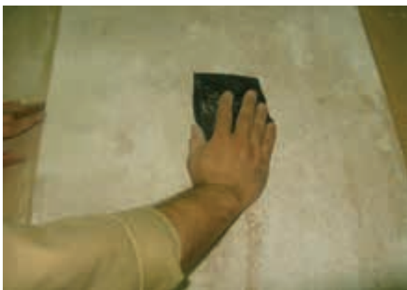
شکل ۴۹-۶- سنباده‌کاری (روی سطح بتونه سریشی).
