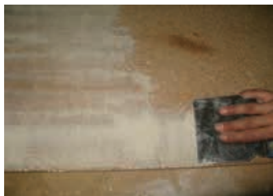
شکل ۳۱۵-۶- بتونه‌کاری نوع پوششی.
