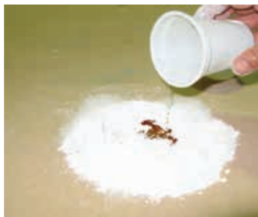
شکل ۲۳-۶- اضافه نمودن آب به بتونه روغنی.
