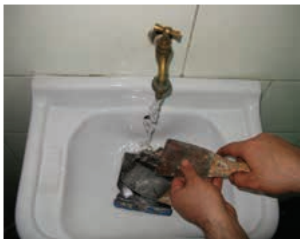
شکل ۱۷-۶- شستن و تمیز کردن لیسه و کاردک.
