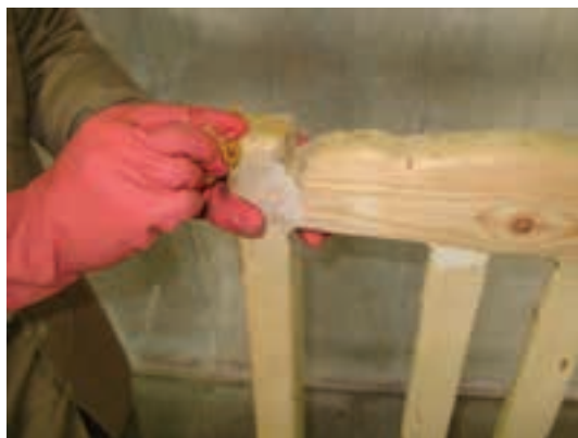
شکل ۳۱۴-۶- بتونه‌کاری غیر پوششی.
