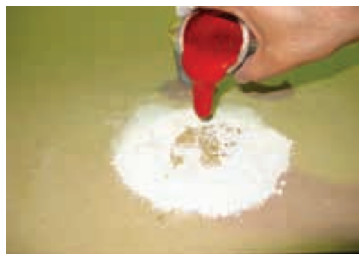
شکل ۲۴-۶- اضافه نمودن روغن الیف به بتونه روغنی.
