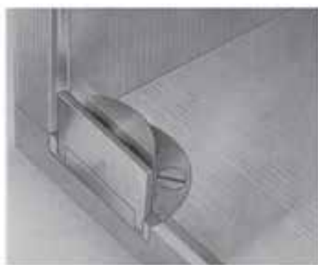
شکل ۳-۷۳-تصویر لولای پاشنه‌ای نصب شده و اندازه‌گذاری پایه نیم دایره جای لولای پاشنه‌ای
