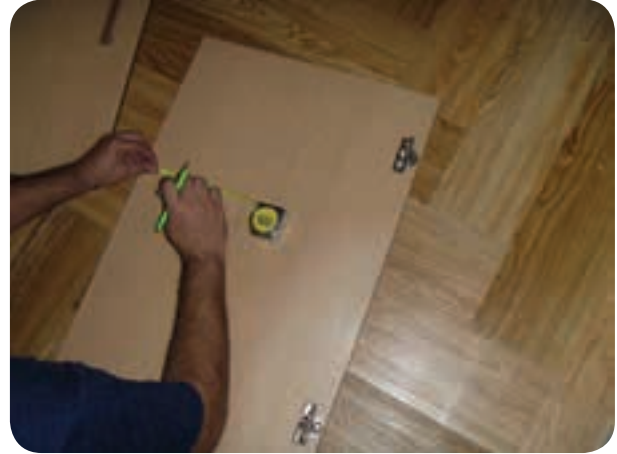
شکل ۱۶۹-۵ نصب لولای در کمد
