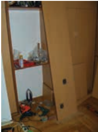
شکل ۱۴۵-۵ نصب یراق مقرر پایه‌های جک تخت‌خواب روی بدنه
