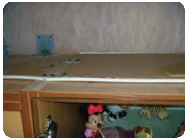
شکل ۲۰۱-۵ اتصال قسمت‌های مختلف دکور به یکدیگر و به دیوار
