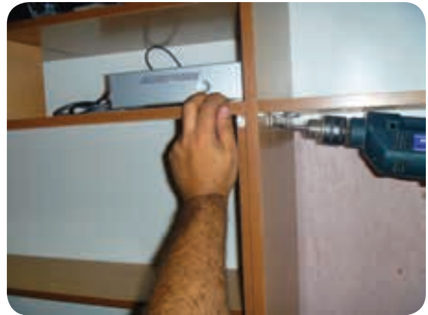
شکل ۱۶۱-۵ استفاده از اتصال گونبای فلزی در نصب طبقات
