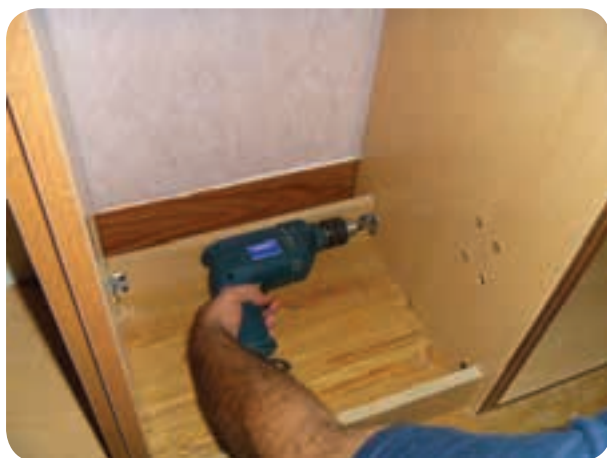
شکل ۲۰۰-۵ نصب پاسنگ‌ها
