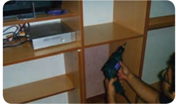
شکل ۱۹۲-۵ نصب صفحه میز آرایش
