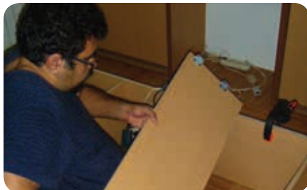
شکل ۱۸۱-۵ نصب طبقات به وسیله گونیاها فلزی
