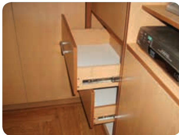
شکل ۱۹۷-۵ نصب کشویی تلسکوپی سه ريله برای کَشو
