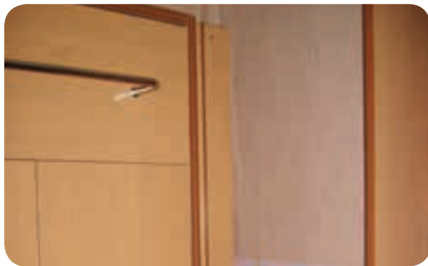
شکل ۱۴۳-۵ نصب مانع پشت در قبل از نصب سقف کمده لباس
