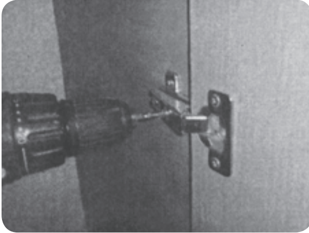
شکل ۱۷۱-۵ جاسازی و نصب لولای در کمد لباس
