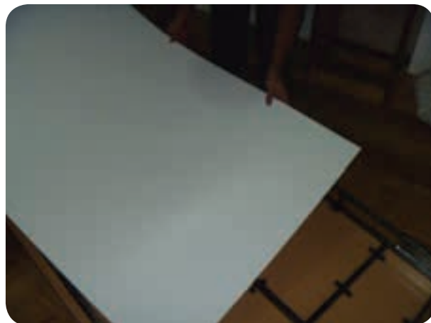
شکل ۱۵۳-۵ نصب ورق فیبر در کف کلاف فلزی (زیر تشک)
