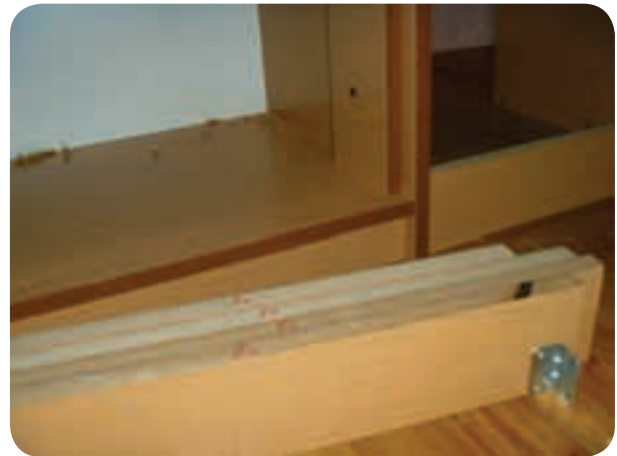
شکل ۱۸۶-۵ نصب پاسنگ با استفاده از گونیا فلزی
