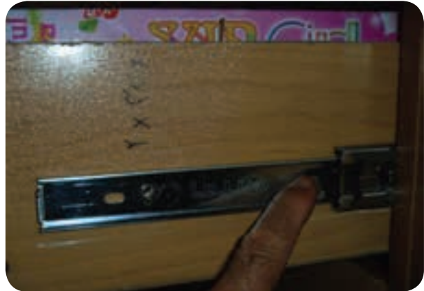
شکل ۱۷۷-۵ ضامن قفل و آزاد کردن کشو با ریل تلسکوپی
