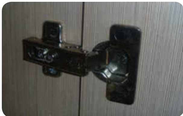
شکل ۱۸۳-۵ نصب لولای گازی فنردار به در کمد
