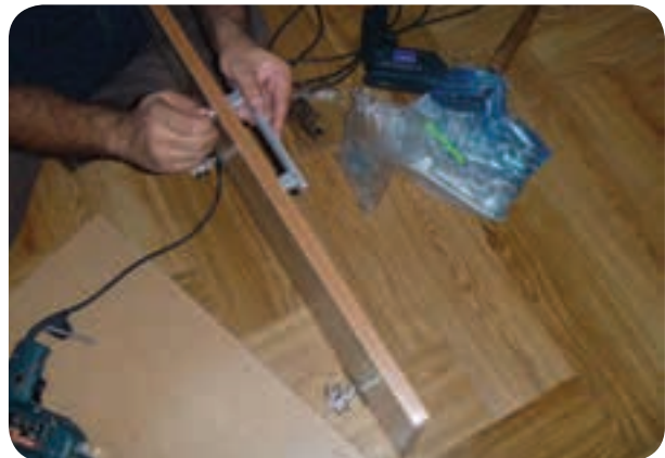
شکل ۱۷۸-۵ نصب دستگیره در کمد
