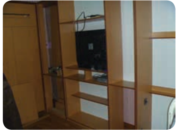
شکل ۱۸۹-۵ دو بدنه عمودی برای ایجاد میز آرایش و کشو
