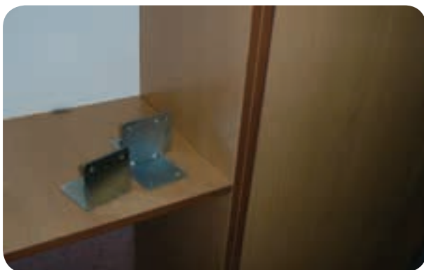
شکل ۱۲۹-۵ بدنه های مقر تخت خواب از دو ام دی اف ۱۶ میلی متری
