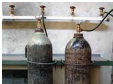
شکل ۲۳-۲- کپسول اکسیژن که به خط لوله گاز می‌رساند.
