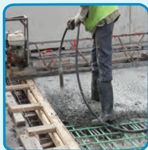
شکل ۱۴-۳- ویبراتور یا لرزاننده بتن داخل قالب
