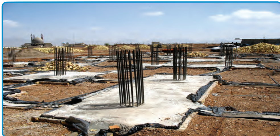
شکل ۱۰-۳- استفاده از پلاستیک در پی
