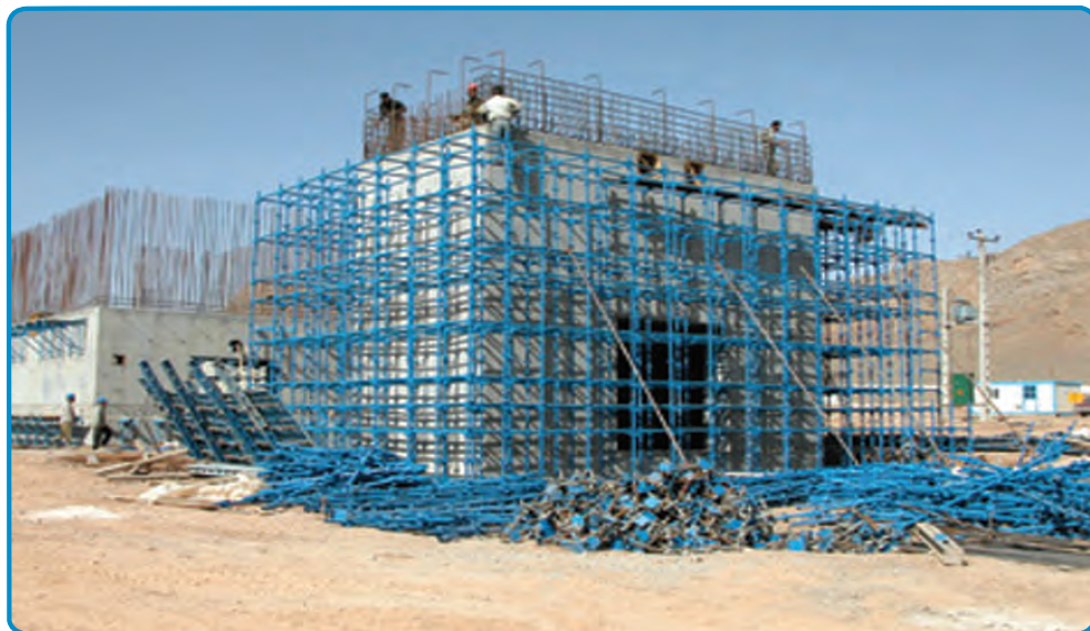
شکل ۳-۲۶- داربست فلزی
