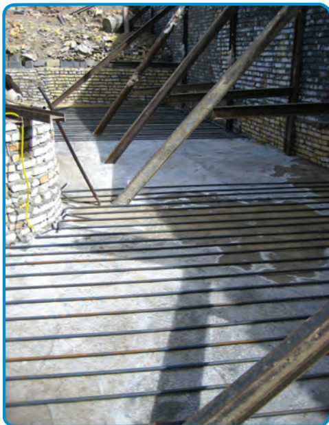
شکل ۳-۴۶- میلگرد طولی کف پی
