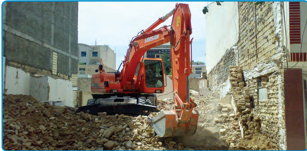
شکل ۳-۲- خاکبرداری با ماشین
