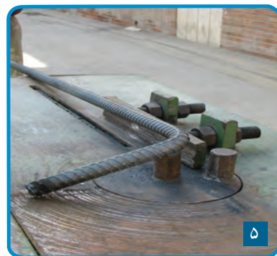
شکل ۳-۶۴- خم کردن میلگرد
