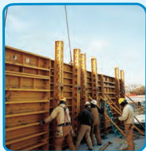
شکل ۳-۳۶- قالب فایبر گلاس برای اجرای دیوار بتنی
