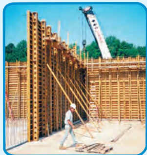
شکل ۱۹-۳- اجرای دیوار بتنی فایبر گلاس برای
