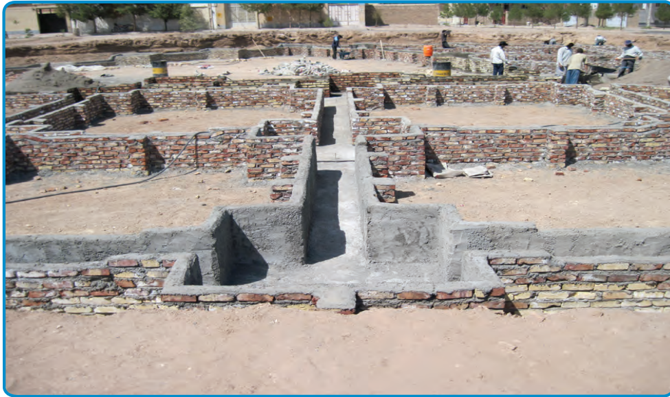
شکل ۳-۲۹- قالب آجری برای اجرای پی
