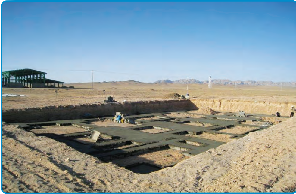
شکل ۳-۶- گودبرداری در زمین‌های نامحدود
