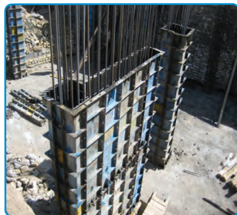
شکل ۳-۳۵- قالب فلزی برای اجرای دیوار بتنی
