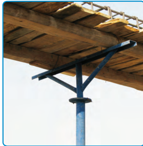
شکل ۳-۲۱- استفاده از شمع‌های فلزی جهت نگهداری قالب‌ها
