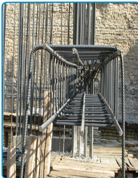
شکل ۳-۴۵- میلگرد طولی در تیر
