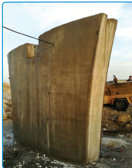
شکل ۳-۴۲- قالب برداری
