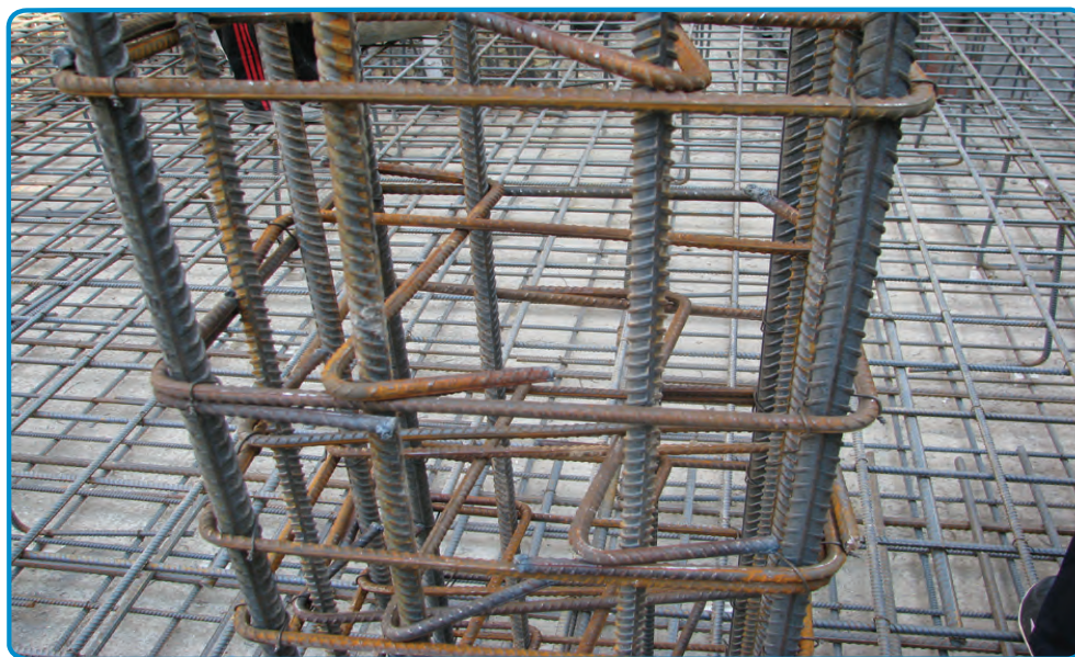
شکل ۵۰-۳- کاربرد سنجاقک در میلگرد گذاری ستون
