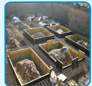
شکل ۳-۳۱- قالب فایبرگلاس برای اجرای پی
