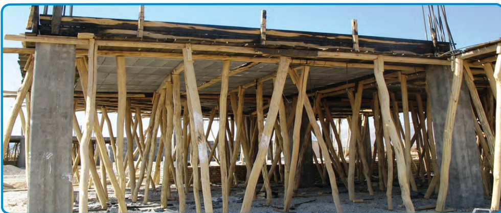
شکل ۳-۲۴- استفاده از شمع‌های چوبی جهت نگهداری قالب‌ها
