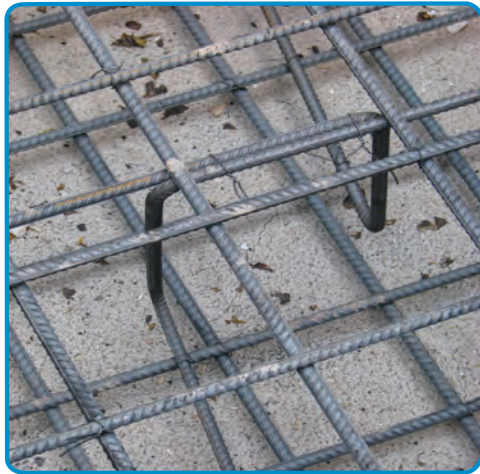
شکل ۳-۵۳- استفاده از خرک در میلگرد گذاری پی
