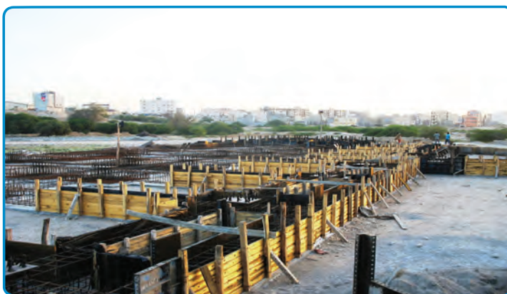
شکل ۳-۲۷- قالب چوبی برای اجرای پی
