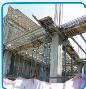
شکل ۳-۳۹- استفاده از قالب چوبی برای اجرای تیر
