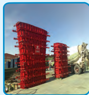
شکل ۱۷-۳- استفاده از قالب فلزی برای اجرای پایه پل
