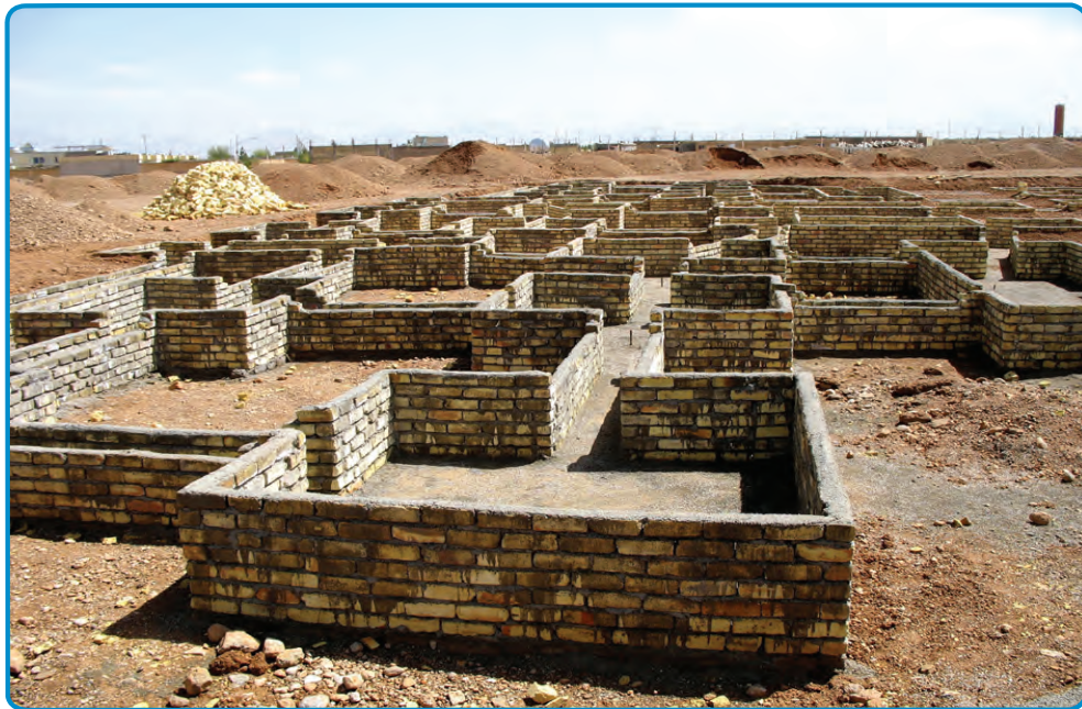
شکل ۱۵-۳- استفاده از قالب آجری برای اجرای پی
