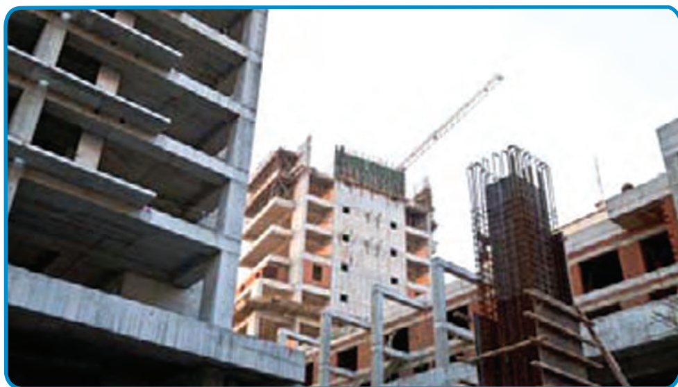
شکل ۱-۲- سازه‌های بتن آرمه
