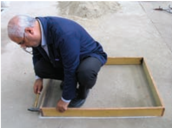
شکل ۴-۱- قالب‌بندی فونداسیون
