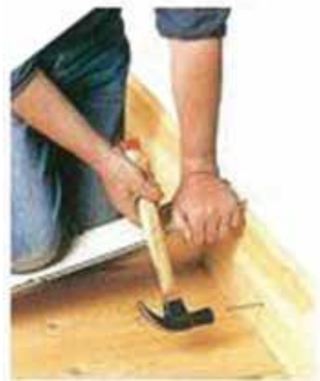
شکل ۳- ۲۹: نصب قرنیز چوبی با میخ
