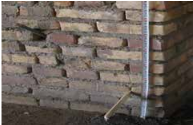
شکل ۳-۳۳: جدا کردن خط تراز روی دیوار
