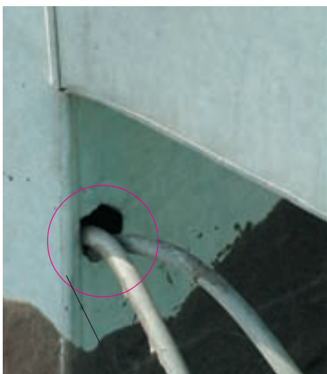
کابل‌کشی در داخل کانال کولر
