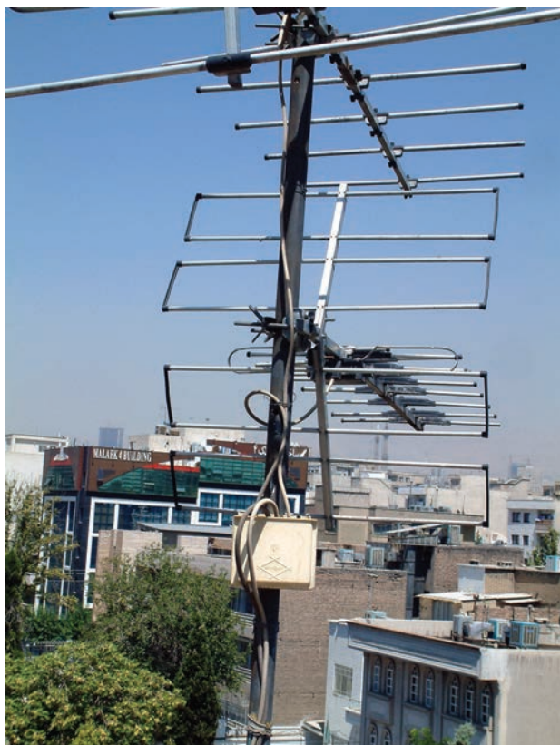
شکل ۷۰-۱ میکسر و محل نصب آن روی دکل آنتن
