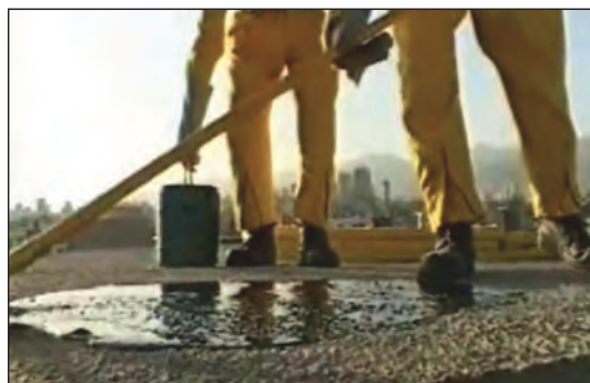
شکل ۲۲-۶ قیرگونی پس از پرکردن بین کُرْم‌ها
