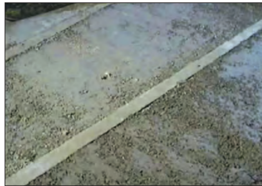
شکل ۲۱-۶ پرکردن فضای بین کرم‌ها با پوکه معدنی
