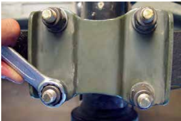
شکل ۳-۶۶- باز کردن مهره‌های کرپی‌ها (پیچ‌های U شکل)
