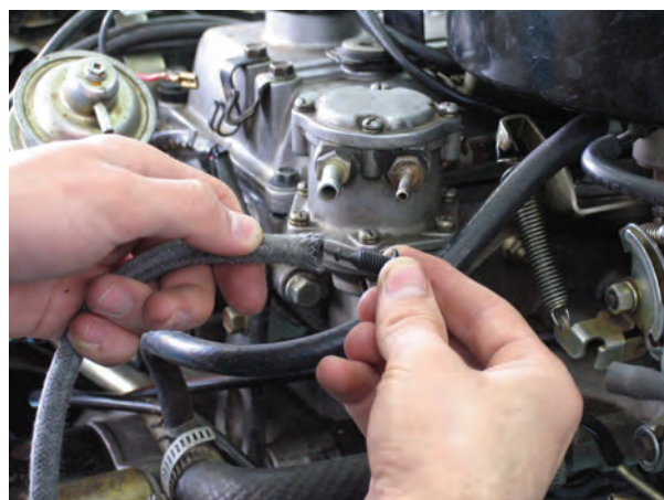
شکل ۱-۴۱ جدا کردن لوله‌ها
