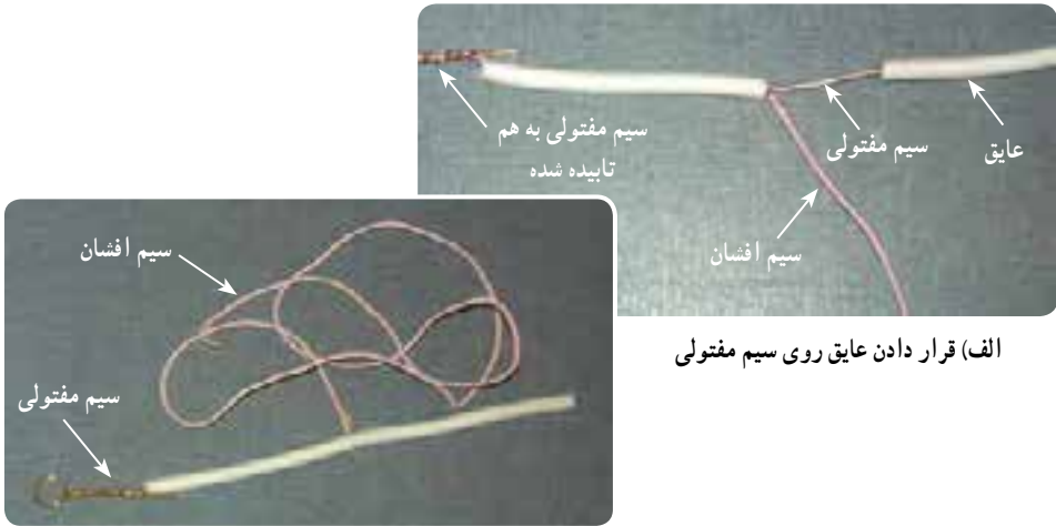
ب) محکم کردن عایق روی سیم مفتولی
