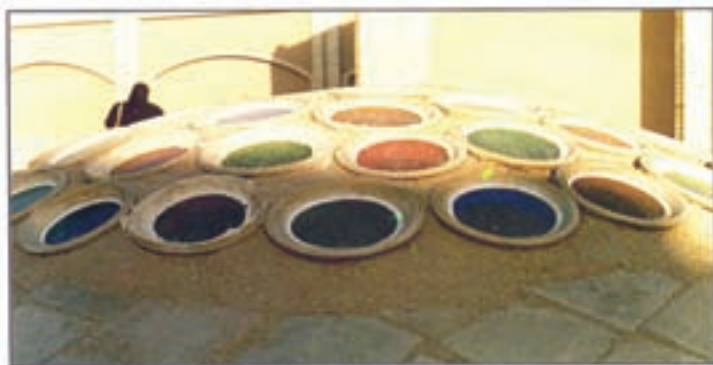
شکل ۲-۱۲- استفاده از گلجام در بازسازی سقف حمام
