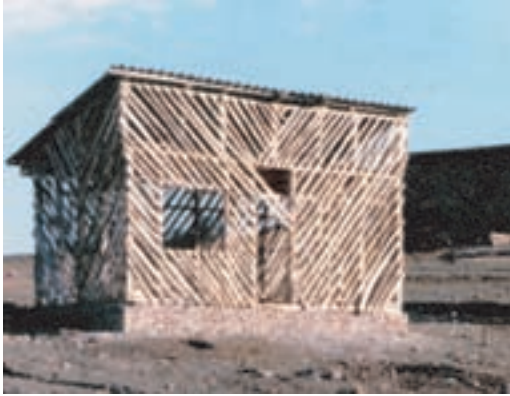
شکل ۹-۱- استفاده از چوب برای ساخت خانه‌های چوبی (زیگالی یا لارده‌ای) در شمال ایران
