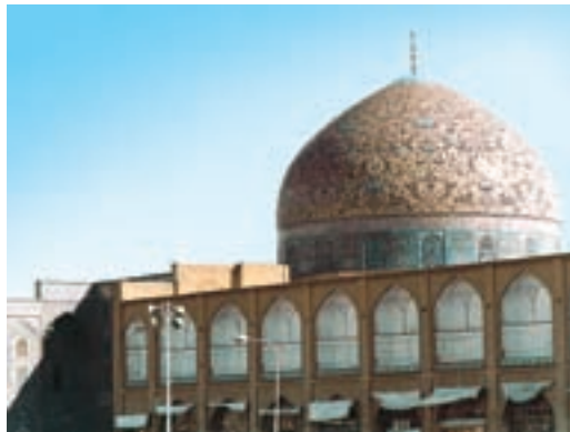
شکل ۱۴-۶- کاشی‌کاری مسجد شیخ لطف‌الله مربوط به عهد صفویه
