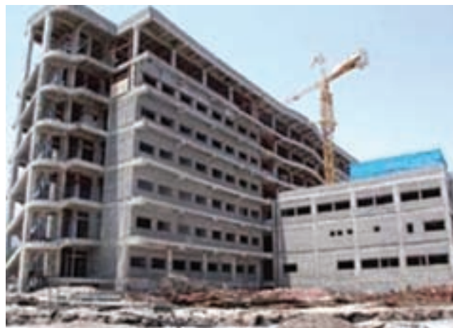
شکل ۱۰-۱۴- عملیات ساخت بیمارستان ۴۰۰ تختخوابی امام رضا(ع)
