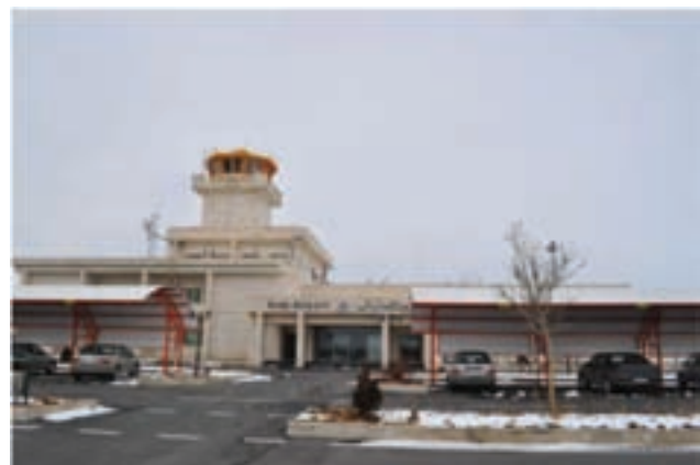
شکل ۱-۶- فرودگاه شهر اراک
